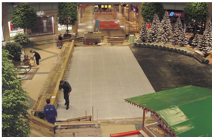
Aufbau der Eisbahn im Eingangsbereich des Allee-Centers in Leipzig-Grünau
