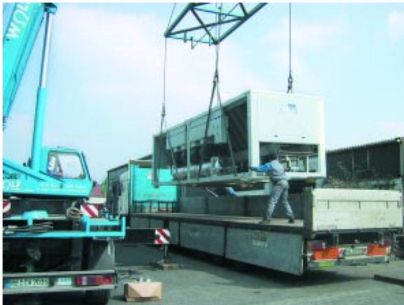
Für den 1.200 kW-Wasserkühlsatz bedurfte es eines Autokrans mit Traverse.
